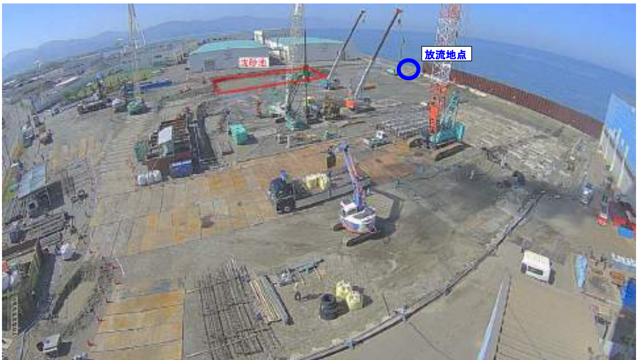
写真 6. 1. 3-1 沈砂池設置状況
