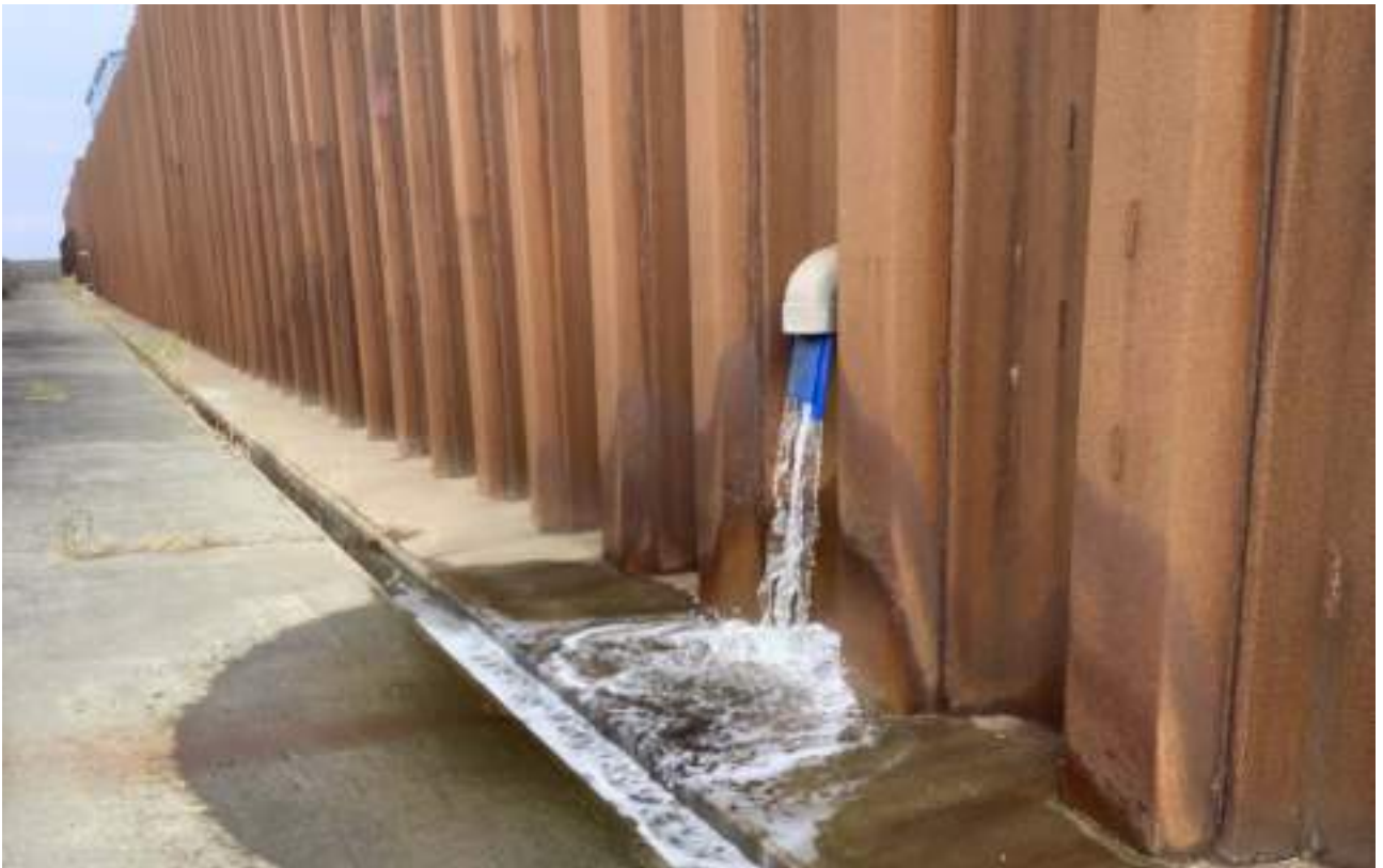
写真 6. 1. 3-2 濁水放流状況
